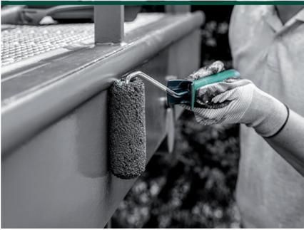
Stark texturierte Filt-Walzen ermöglichen einen besonders gleichmäßigen Farbaustausch durch hohe Faserstabilität und Oberflächenverdichtung. Dadurch kann in kürzester Zeit eine optimale Menge an Lack aufgetragen werden. Im Anschluss ermöglichen superfeine Schaumwalzen mit hohem Raumgewicht und mittlerer Strauchhärte das optimale Finish. Zusammen ergeben sie eine optimale Mischung für die Verarbeitung von allen Lacken.
