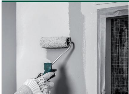
Mittlerweile werden im Innenbereich fast ausschließlich wasserbasierte Produkte eingesetzt. Im Außenbereich dominieren aber nach wie vor die lösemittelhaltigen Lacke. Denn dort überzeugen lösemittelhaltige Lacke durch ihre Haftungseigenschaften und die Verarbeitung. Um diese Lacke optimal verarbeiten zu können, bedarf es Lackierwalzen mit einer hohen Festigkeit und einem hohen Materialauftrag.
